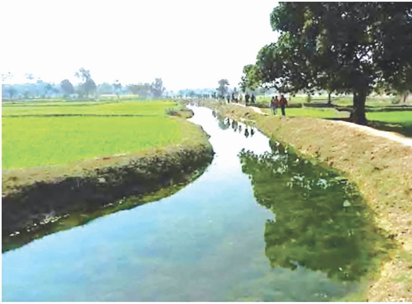
दक्षिण बिहार में आहर-पड़न प्रणाली बहते पानी को घेरने वाले आयताकार बांधयुक्त क्षेत्र और पहाड़ी नदियों के पानी को खेतों तक पहुंचाने का माध्यम है।
